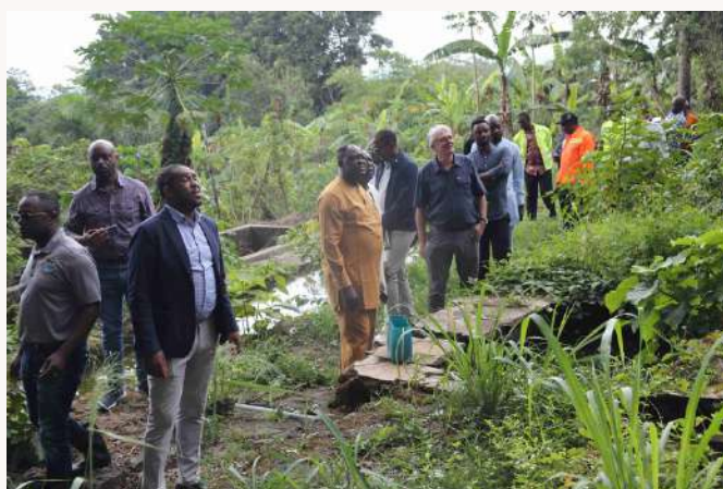
Evaluation du chantier.
